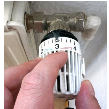
Thermostat-Kopf für manuelle Bedienung [Quelle: energie-experten.org]
