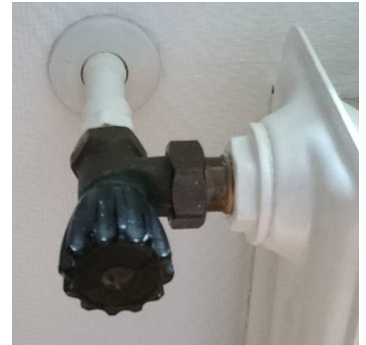
Veraltetes Stell-Ventil [Quelle: energie-experten.org]
